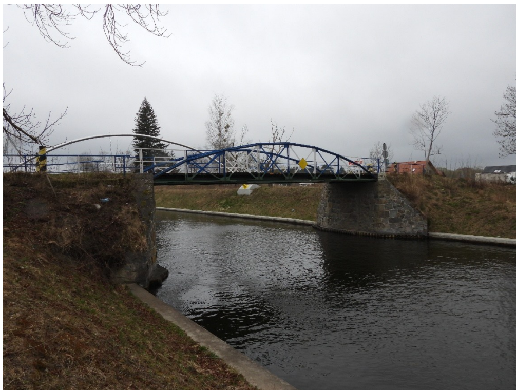
Fot. 29. Przeszkoda, kanał – brak widocznych uszkodzeń.
