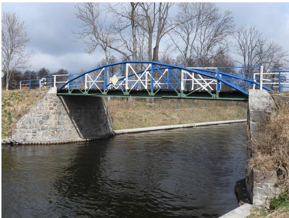
Fot.1. Przęsło – widok z boku.
