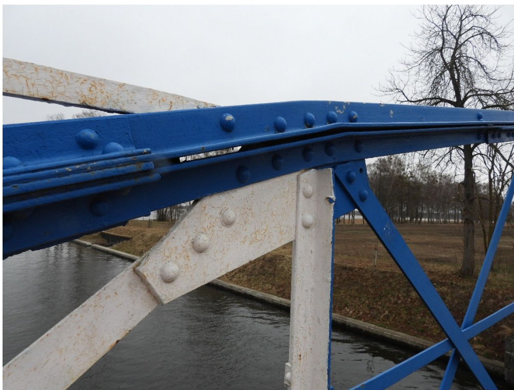
Fot.2. Przęsło – lokalne ogniska korozji i zniszczenia zabezpieczeń antykorozyjnych.
