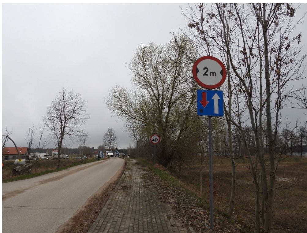
Fot. 27. Ograniczenia na obiekcie - 2,5t, 2m szerokości oraz ruch mijankowy.
