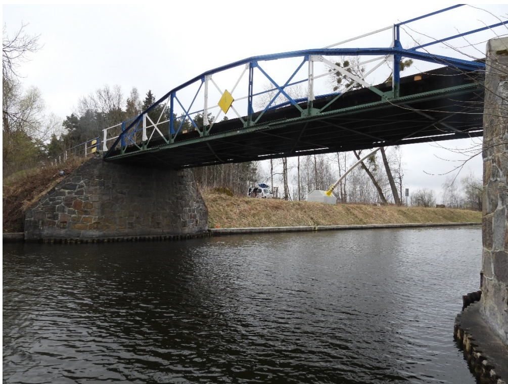
Fot. 28. Przeszkoda, kanał – brak widocznych uszkodzeń.
